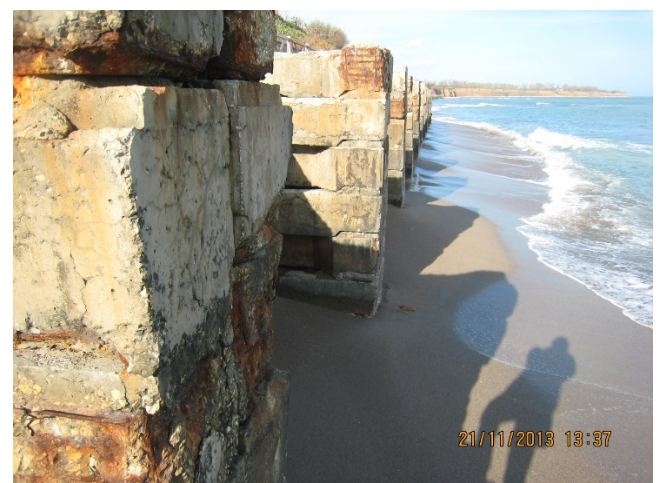
Сн. 7 и 8 – нарушено бетонно покритие на брегозащитните стени – 2013 г.
