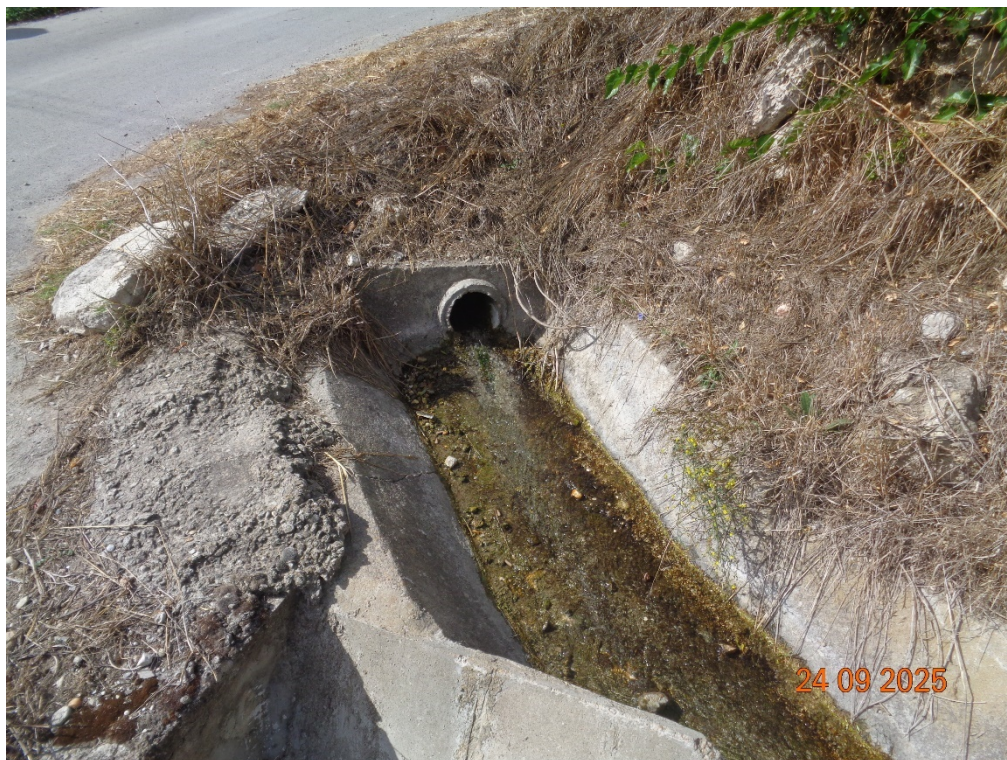
Сн.8: Траншееен дренаж, заустен в пътната канавка.
