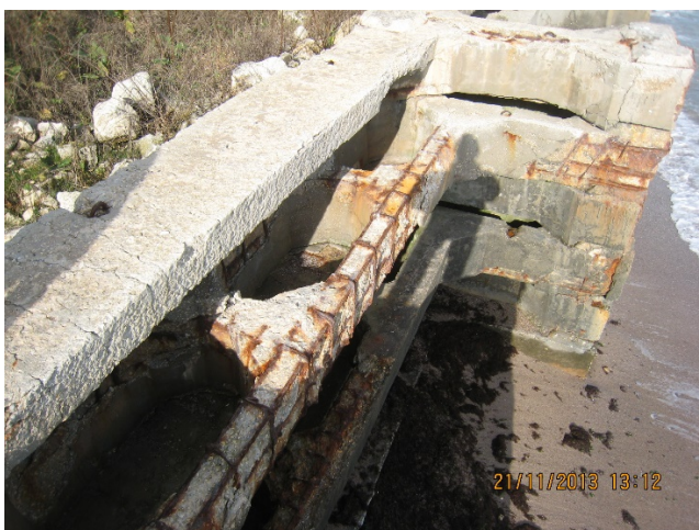
Сн. 7 и 8 – нарушено бетонно покритие на брегозащитните стени – 2013 г.
