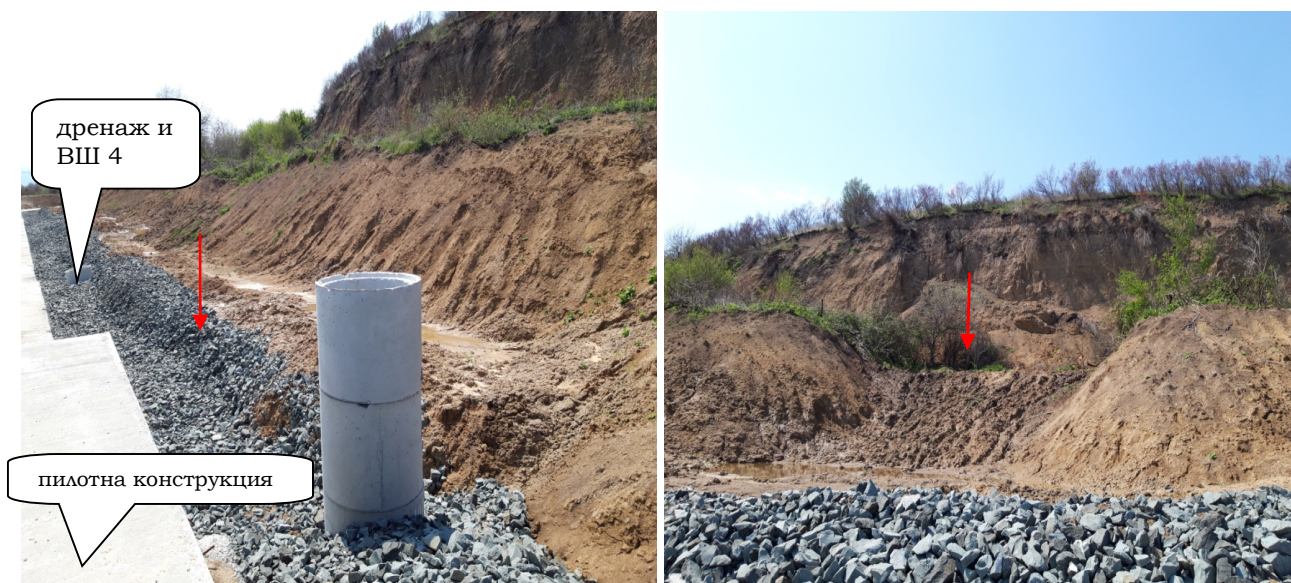
вал на изгласкване 16.04.19 г. траншея в свлачището
