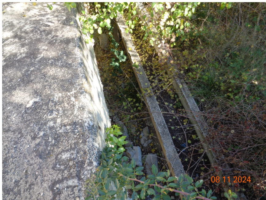
Сн. 12: Отцепена бетонна канавка
