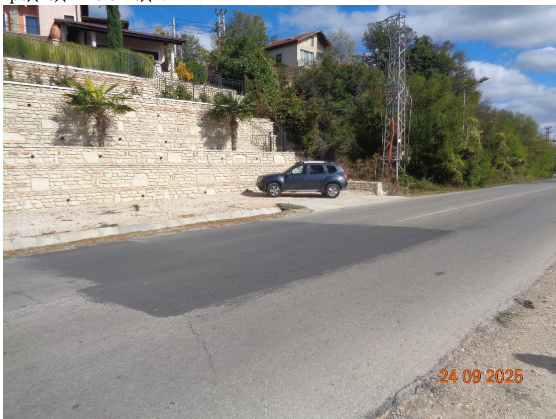
Сн.1: Свлачищната пукнатина, тангираща по отстъпа на свл. Свилоза, е заличена
