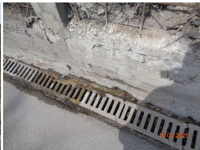
Сн.4. Дениране на води, задръстена канавка
