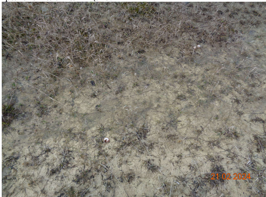
Почвени води избиват по повърхността на терена в основата на склона
