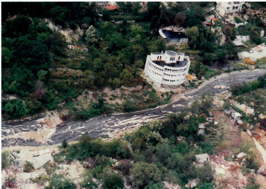
Снимка 1: Свлячище „Кабакум“ през април 1997 г., разрушеният път IV-90023 и „наклонената къща“
